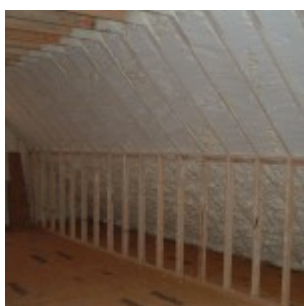
Hotová zaklopená podlaha
