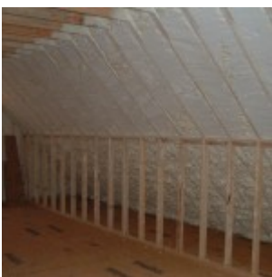
Hotová zaklopená podlaha
