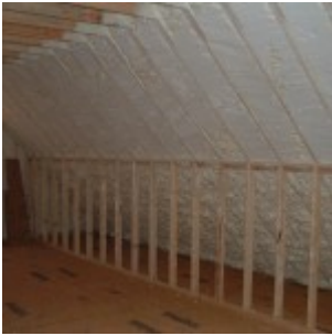
Hotová zaklopená podlaha
